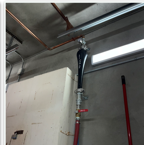
R10x avec adaptateurs victaulic (mâle) 1 1/4" installé verticalement avec une tuyauterie en plastique ajoutée après le système comme point de rupture prédéterminé.
