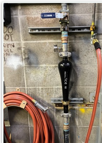
R10x avec adaptateurs victaulic (mâle) 1 1/4" installé verticalement avec une tuyauterie en plastique ajoutée après le système comme point de rupture prédéterminé.
